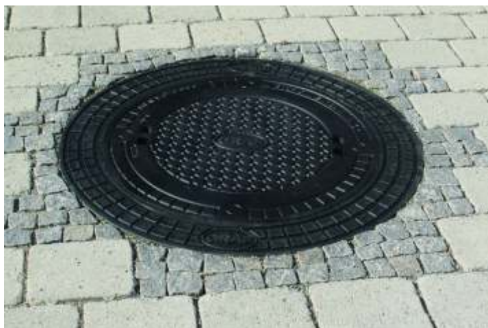
Izgled po vgradnji v parkirišču.
